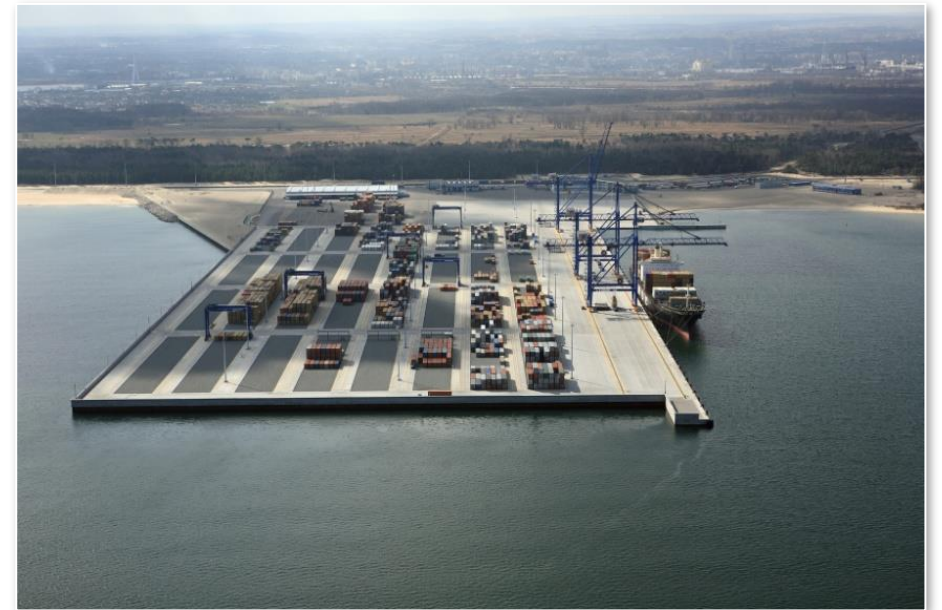
Quai à containers | Gdansk | PL
