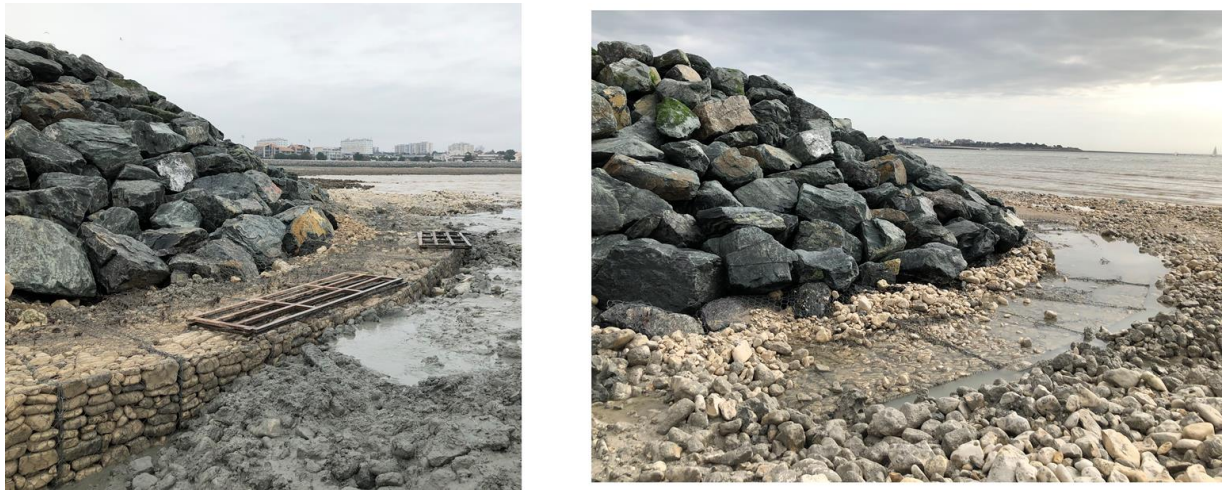
Figure 3: (gauche) Prise de vue de du des gabions en phase de remplissage. (droite) Prise de vue de l'installation finale, et de son intégration à l'ouvrage.
