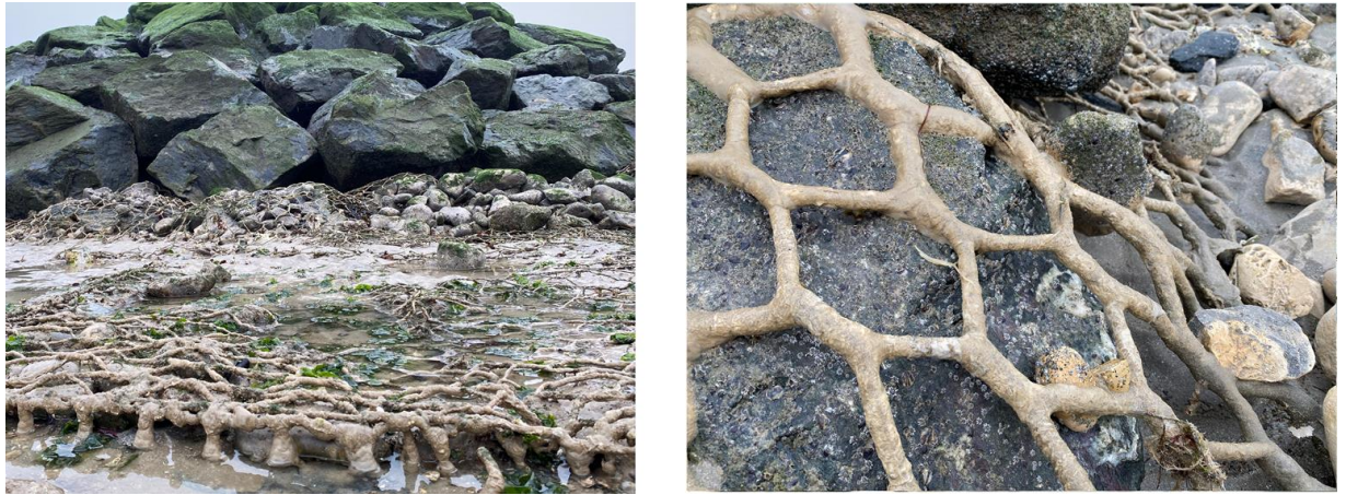
Figure 4: (gauche) Prise de vue de la partie supérieure des gabions 8 mois après la mise en service. (droite) Prise de vue du filet rendu solide des enrochements grâce au géocorail.
