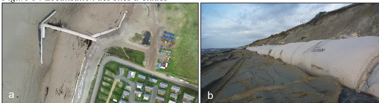
Photo 1 : Géotubes disposés en épi en T (a) ; posés en pied de dune (b)
