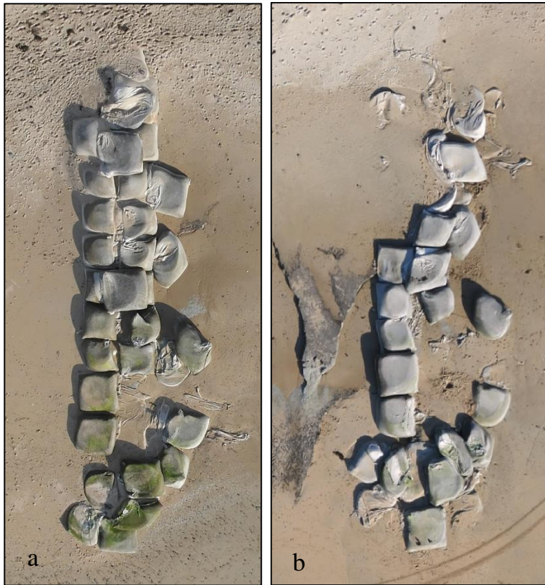
Photo 7 : Vues verticales de l'épi expérimental de Saint-Jean-le-Thomas en novembre 2019 (a) à l'issue de la tempête Eleanor et octobre 2020 (b) à l'issue de la tempête Ciara.
